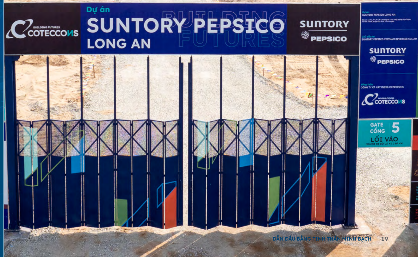
Dự án Suntory Pepsico do Coteccons đảm nhận công tác xây dựng.
